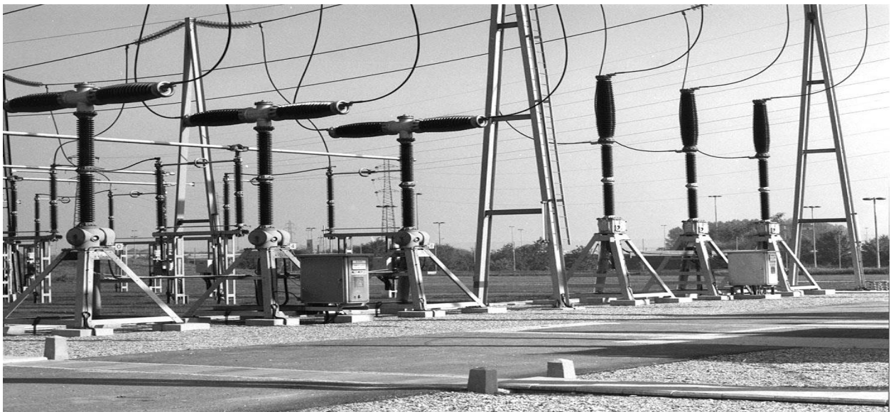
Fig. 1.2 : Deux générations de disjoncteurs ouverts : 245 kV ; 40 kA ; 50 Hz
