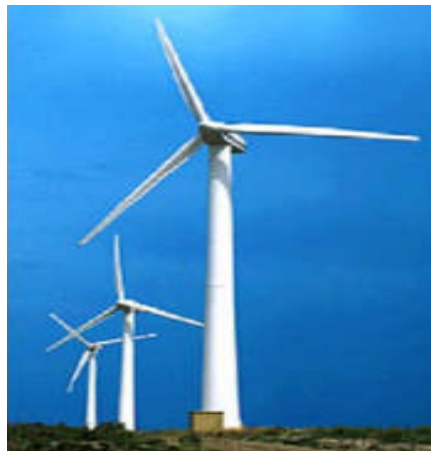
Fig. I. 3 Eolienne à axe horizontal
