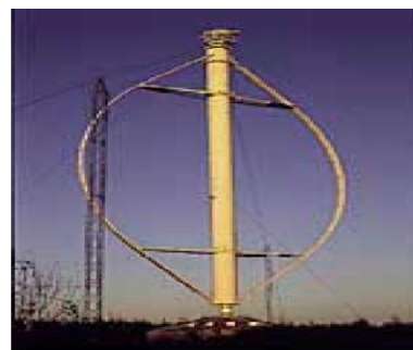
Figure I.5 : Eolienne de Darrieus [Boy 06]
