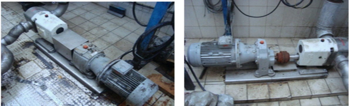
Figure 2 – 21 : Pompe de soutirage de l'huile
