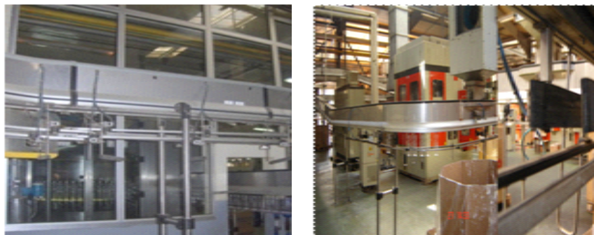
Figure 2 – 5 : Convoyeur aéraulique rafale
