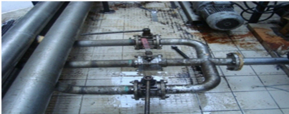
Figure 2 – 20 : Vannes de sélection
