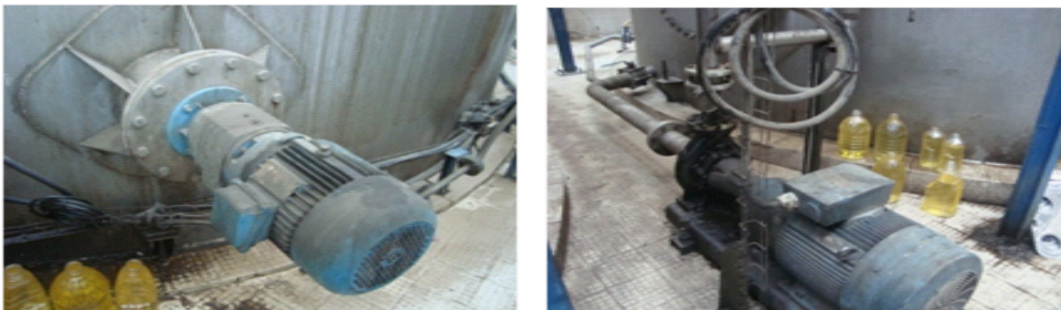
Figure 2 – 22 : Pompe de recirculation
