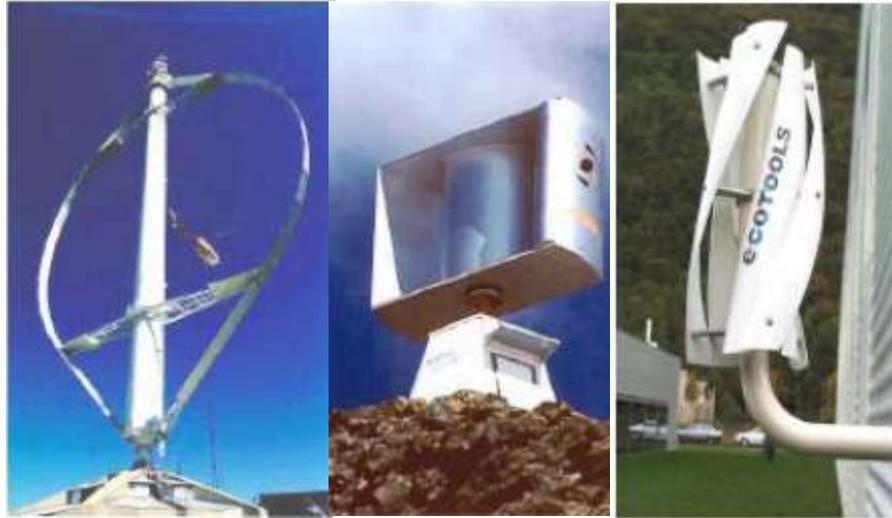
Fig. I.7. Eoliennes à axe vertical
