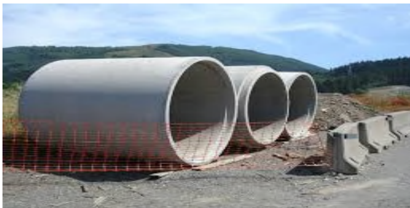
Figure (V-1) : Conduite en béton.
