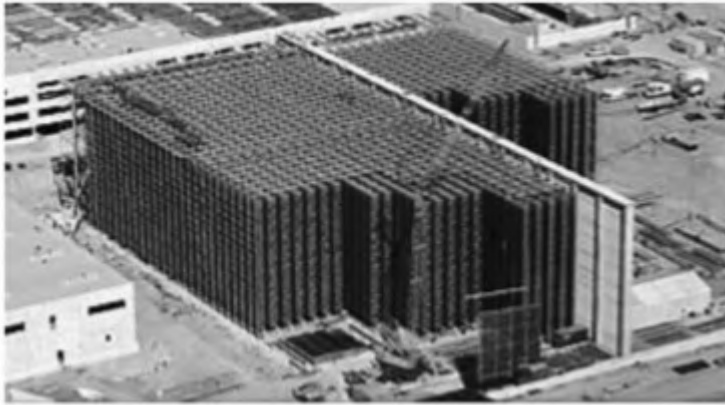
Figure N° 17 : Stockage de grande hauteur automatique (les transstockeurs) :
