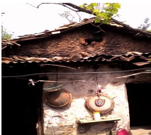
Image N° 01 : Façade extérieure d'une maison traditionnelle à Lânasser.
