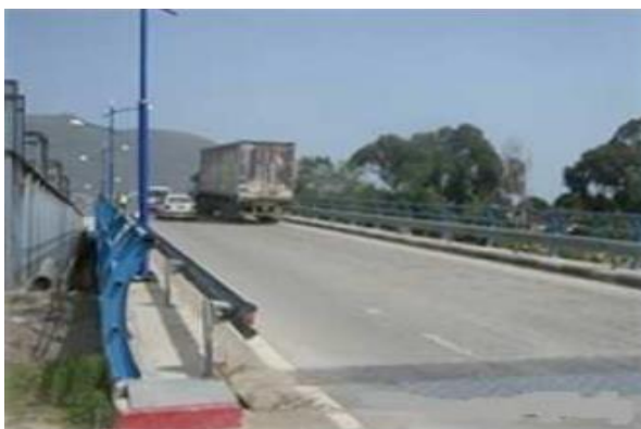
Figure 26 : Nouveau pont de scala.
