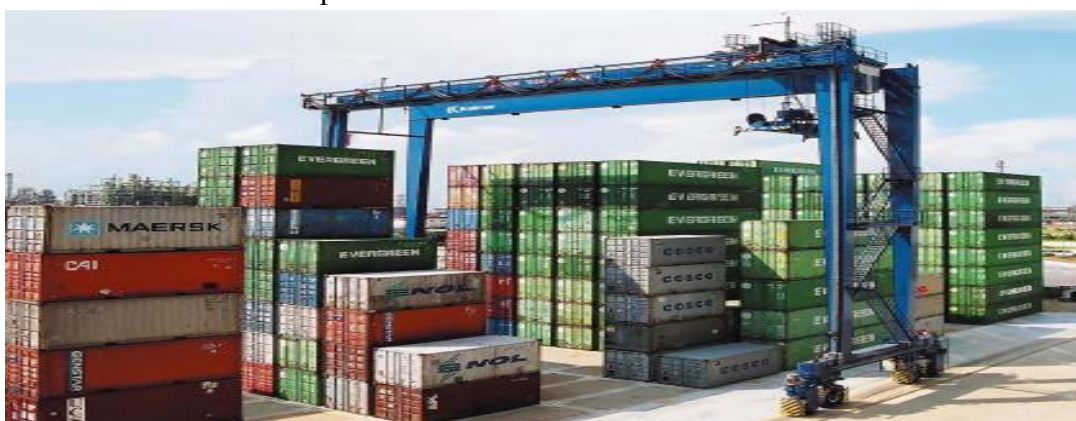
Figure (I.3): Grue portique mobile sur pneus(RTG)
