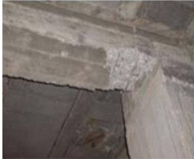
Figure II. 12 : rotule plastique dans la poutre (comportement recherché)([32])
