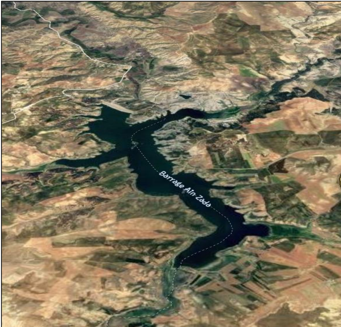
Figure (III.1): Barrage d'Ain Zada prise par Google Earth
