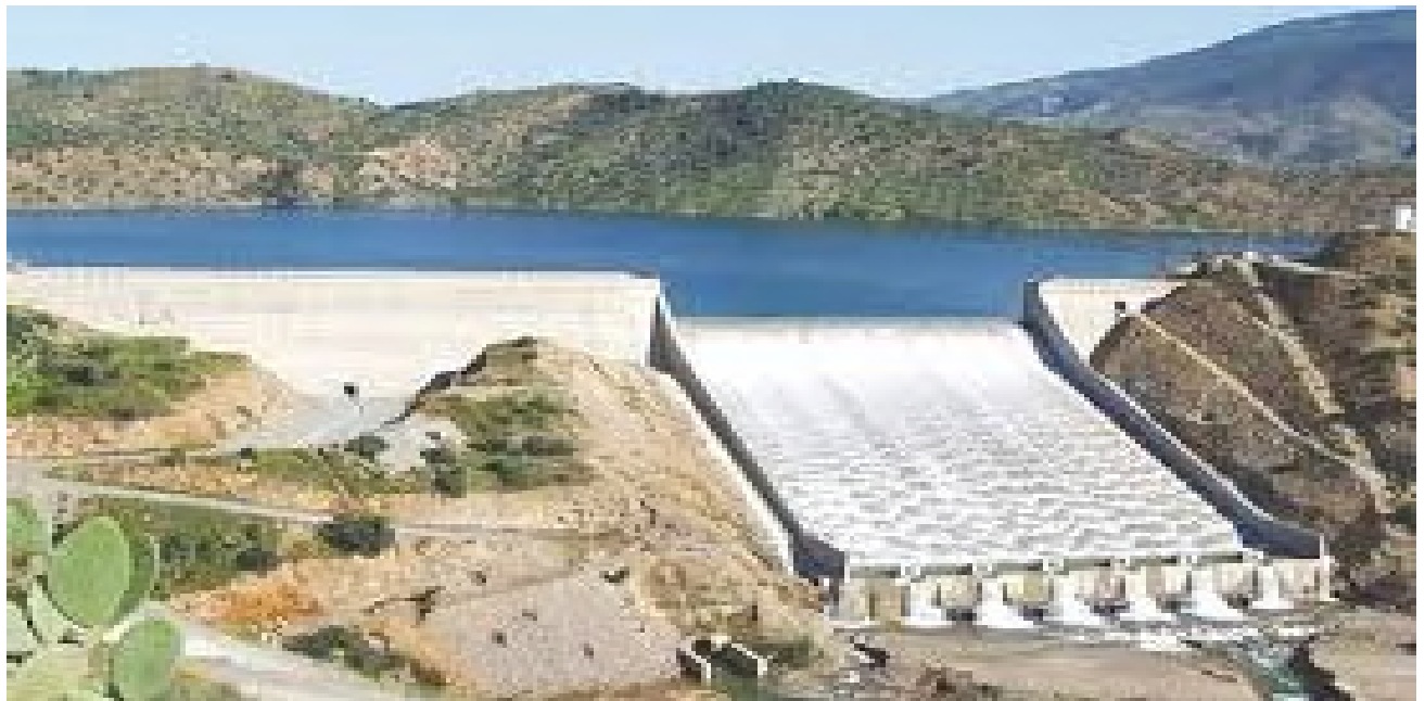
Figure(I.4) : Photo du barrage Tichy-Haf
