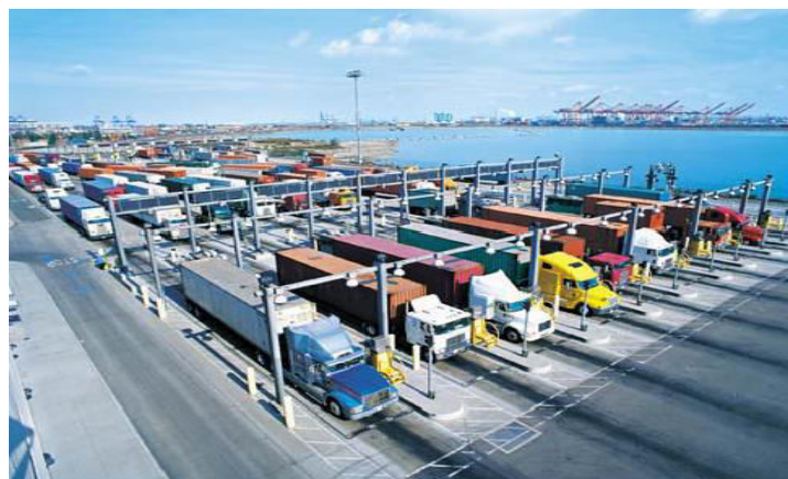
Figure 15 : Guérite d'un terminal de conteneur.
