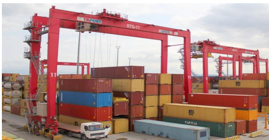
Figure 13 : Pont roulant sur pneumatique au port de salerno en Italie.
