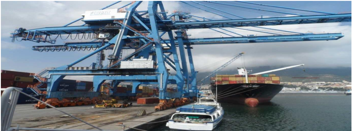
Figure N°09: Portique de quai sur rail
