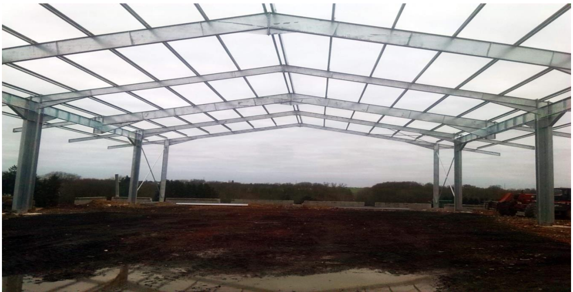
Figure I.3: structure en portique
