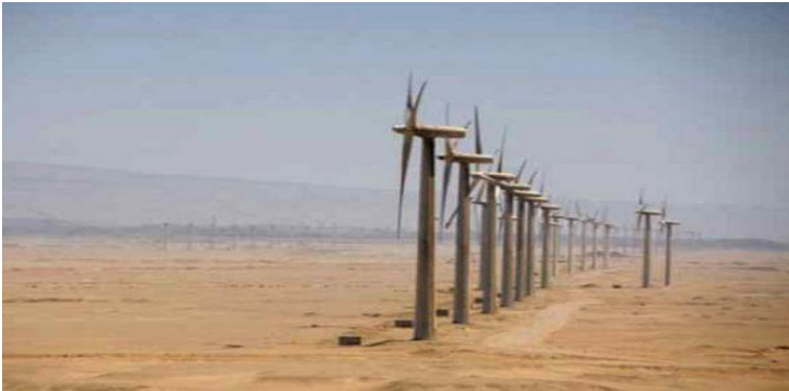
Figure I 1 Ferme éolienne d'Adrar Algérie
