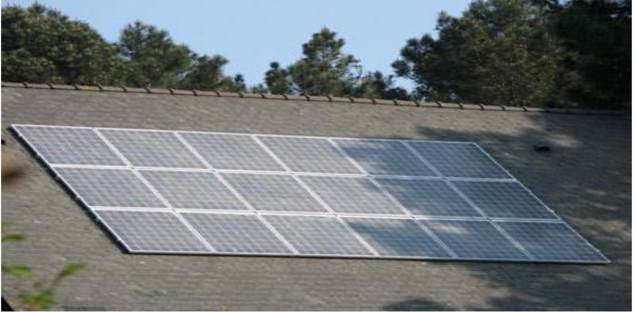
Figure I.23 : GPV dans des contritions partiellement ombragées causées par l'ombre d'un arbre.
