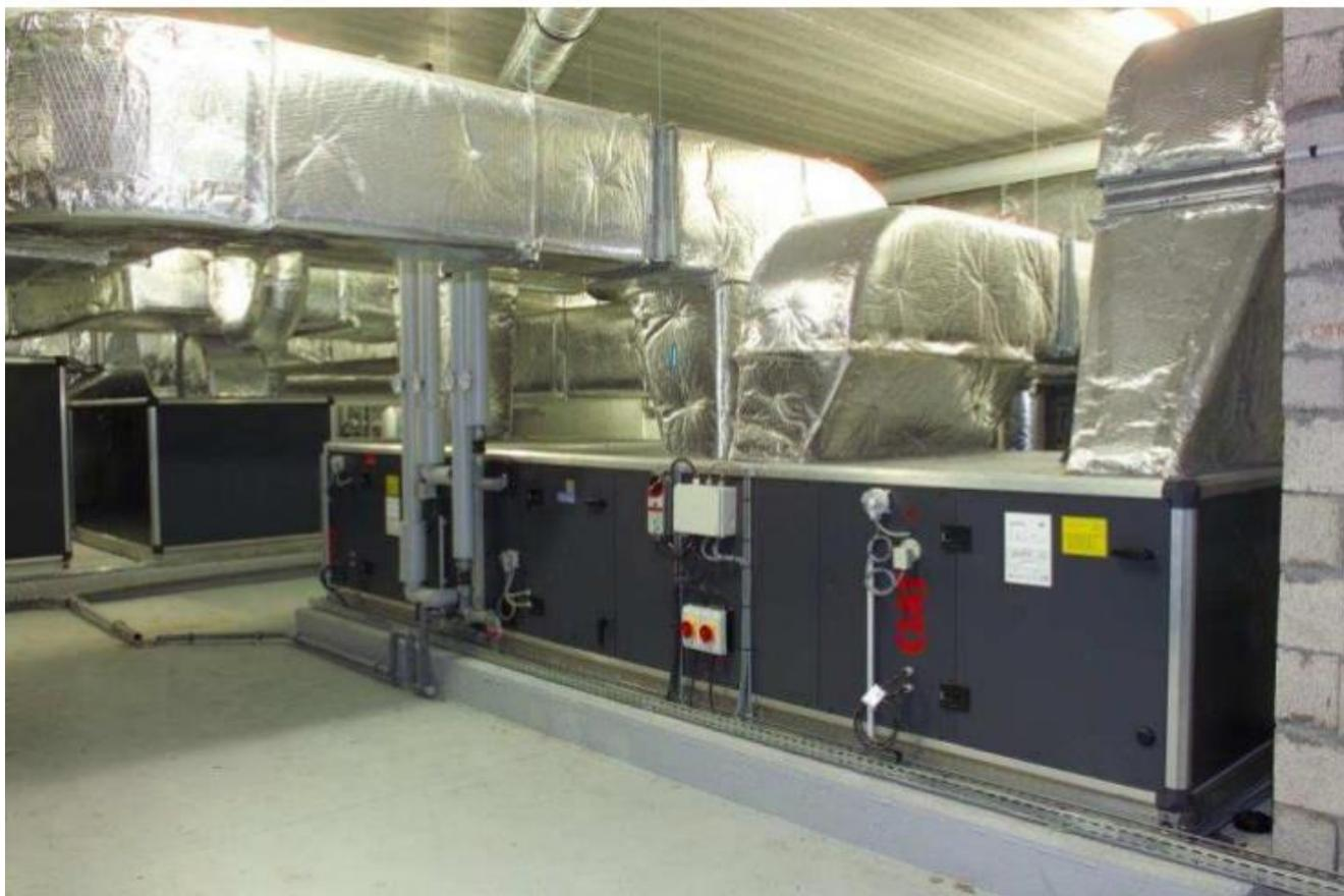
Figure I.14 CTA double flux a récupération.[8]
