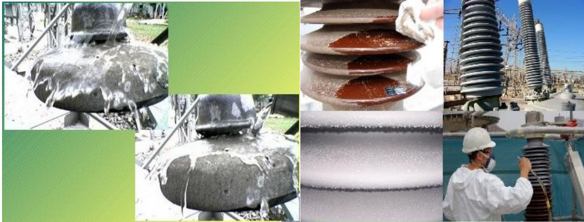
Fig. II. 7: Graissage des surfaces isolantes
