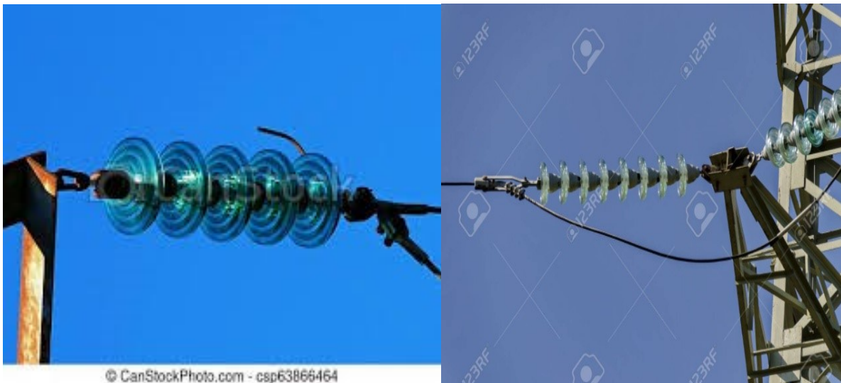
Fig. II. 6: Allongement de la ligne de fuite
