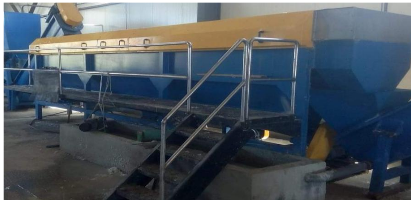
Figure III.19 : Bassin de lavage de films de nylon.
