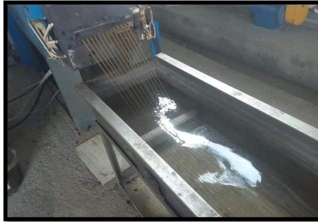
Figure III.29 : Bassin de refroidissement
