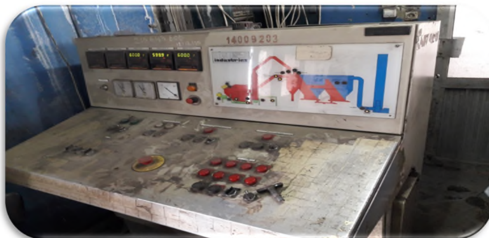
Figure 2.13 : Tour de contrôle.
