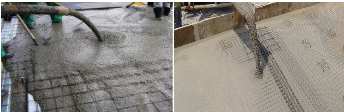
Figure I.3: Application du béton autoplaçant [16]
