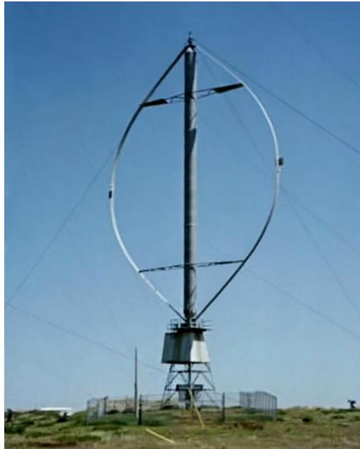
**Figure I.6:**Eolienne à axe vertical de type Darrieus
