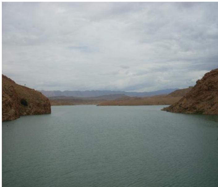
Figure I.8 : La retenue du barrage de Foug El Gherza
