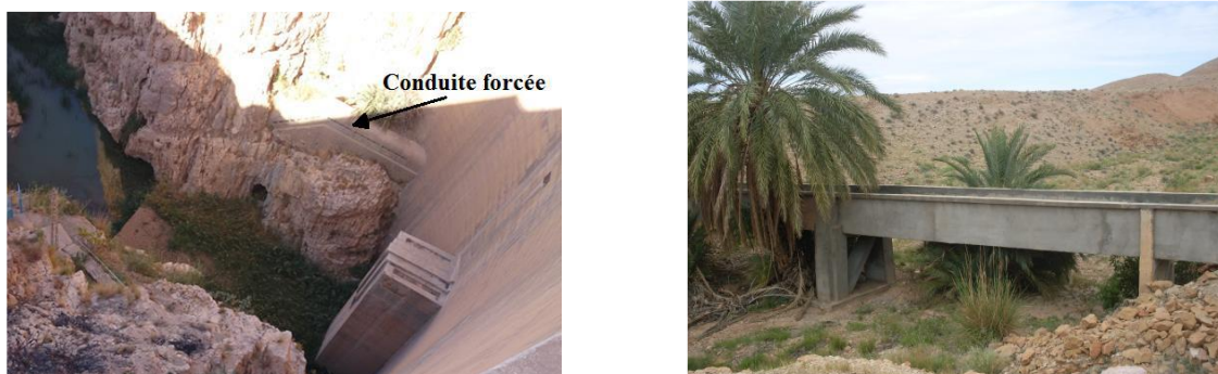
Figure (III.4): Le canal d'irrigation du barrage de Foum El Gherza et conduite forcé
