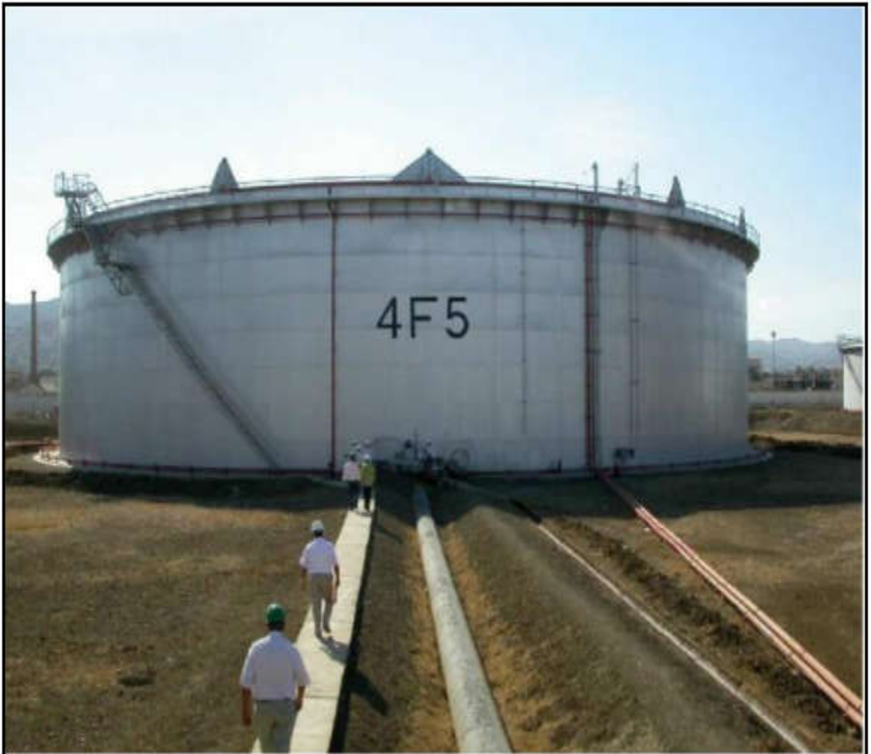
Figure 2 : Vue du bac 4F5 du dépôt nord et sa cuvette de rétention.
