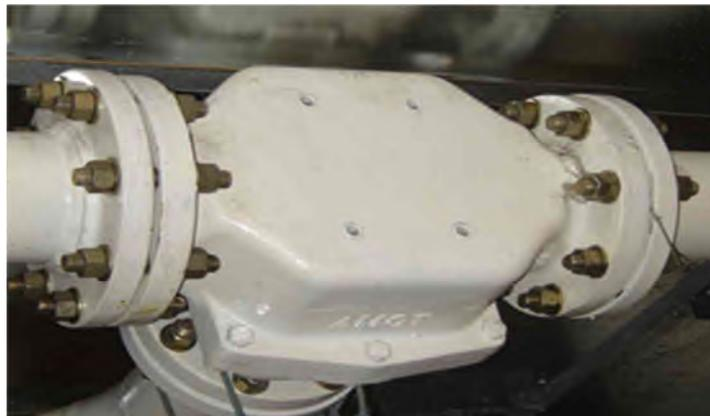
**Figure I.7 :** Vanne thermostatique.
