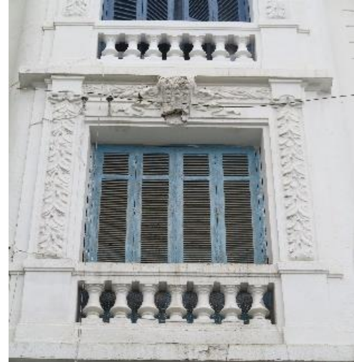
Figure II-81 : Encadrement des fenêtres de l'immeuble de Borge, Bejaia. Source : auteur 2019
