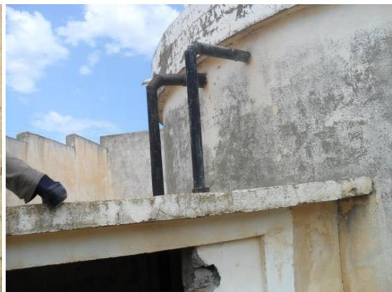
Figure (II. 41) Conduite trop plein et d'arrivée
