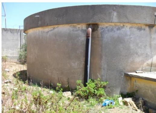
Figure (II. 30) Conduite d'arrivée
