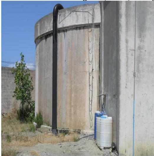
*Figure (II. 19) Système de javellisations*
