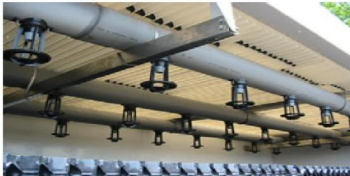
Figure II.22 : Système de dispersion du fluide à refroidir. [8]
