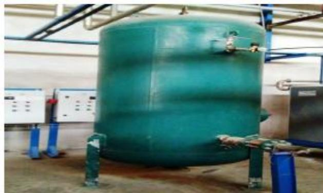
**Figure II.18 :** réservoir d'air.
