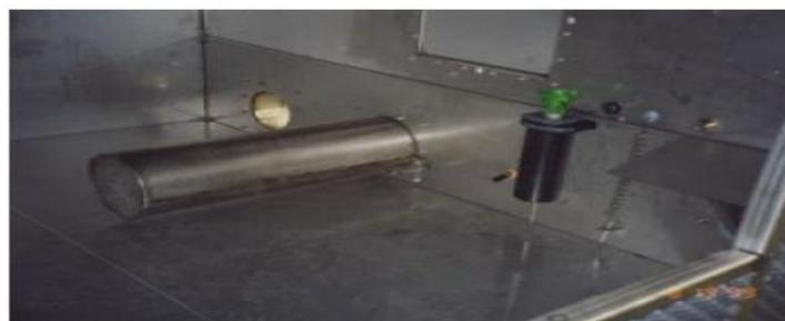
Figure II.23: Exemples de bassin de rétention avec point de vidange.
