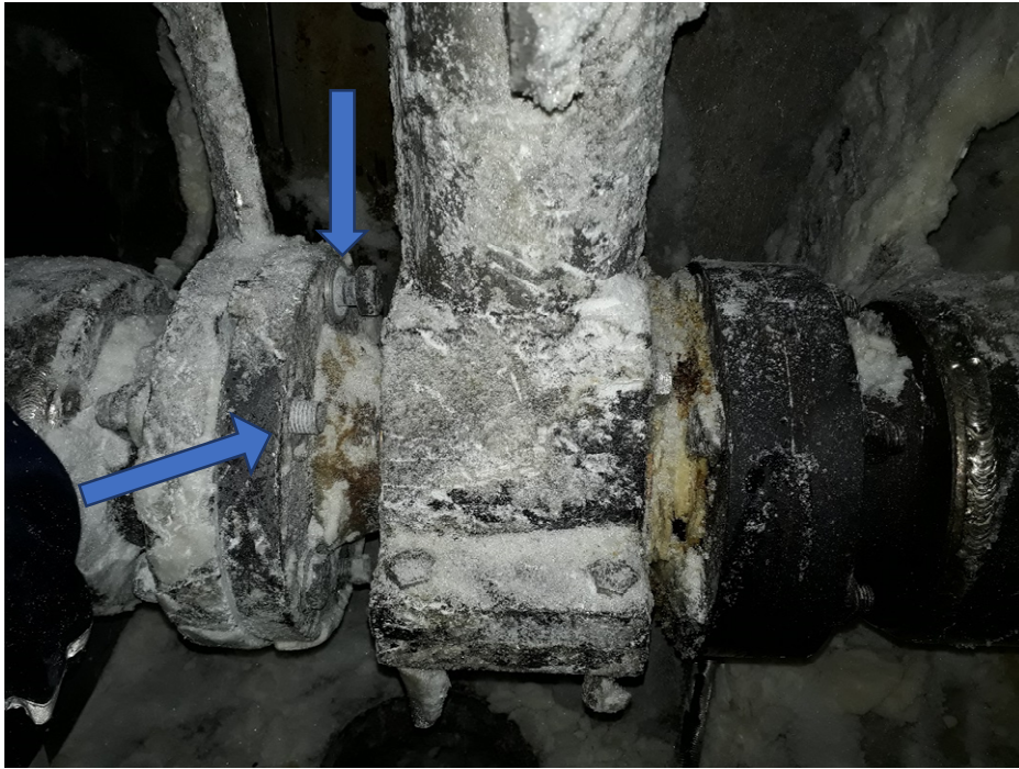
Figure III 5: Les vis desserré
