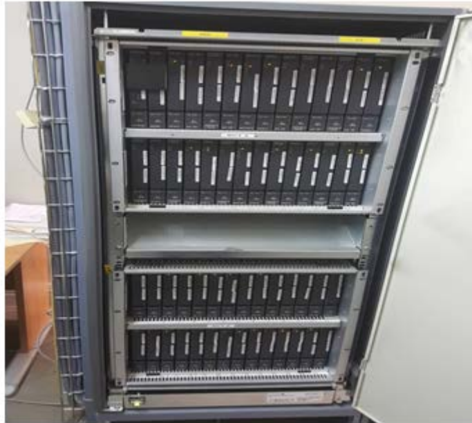
Figure 3.6- Armoire téléphone IP.
