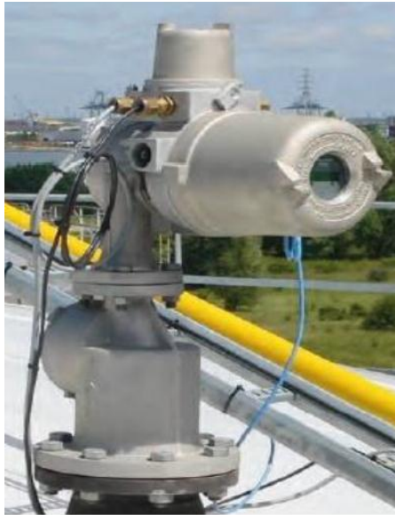
Figure I.11 Jaugeur ENRAF 854 ATG
