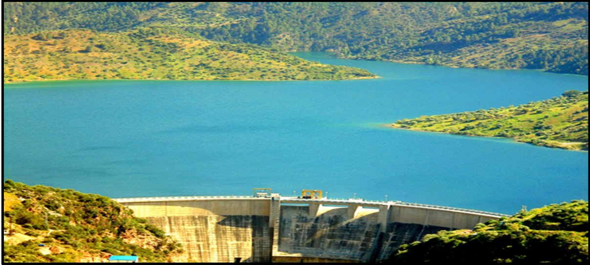
Photo 2 : Station 2 « retenue » à la rive droite du barrage (milieux lentiques).
