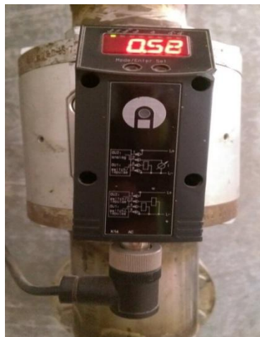
Figure I.7 débitmètre calorimétrique
