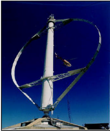
Éolienne de type Darrieus.
