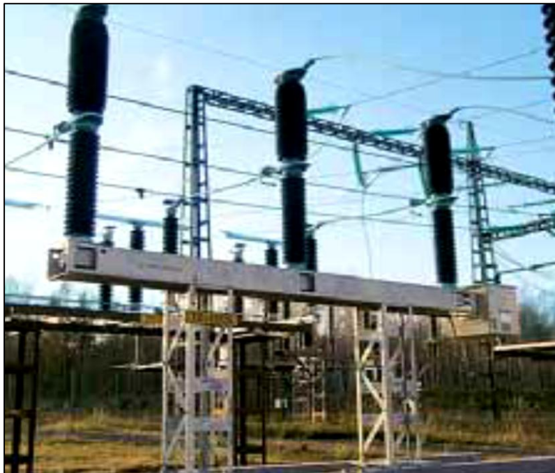
Fig.III.12 : Disjoncteur à cuve sous tension pour un pouvoir de coupure de 40 kA sous 170 kV.
