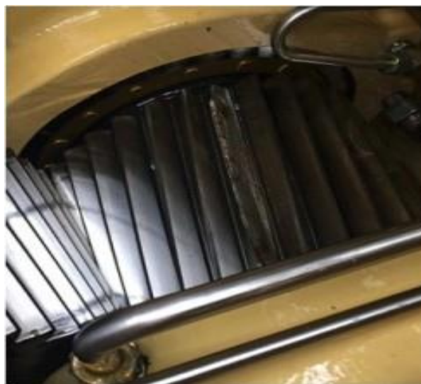
Figure IV.3: pignon d'un multiplicateur de l'éolienne avec défaut [22]
