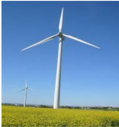
Figure (I- 7) : Eolienne à axe horizontal [3].
