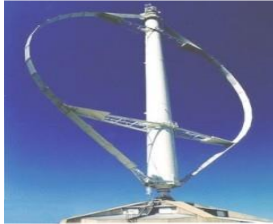
Figure (I- 6): éolienne à axe verticale [3].
