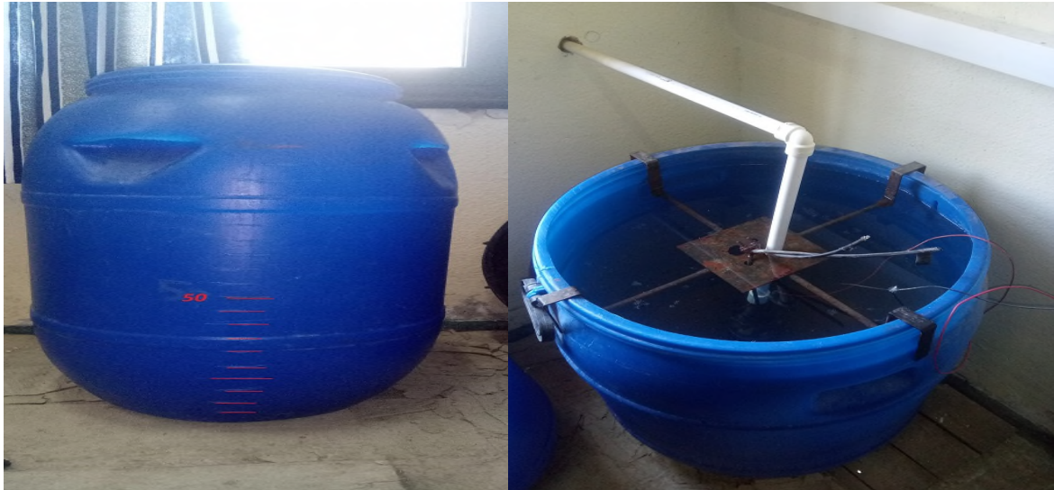
Figure III.4 : Réservoirs d'eau et canalisation.
