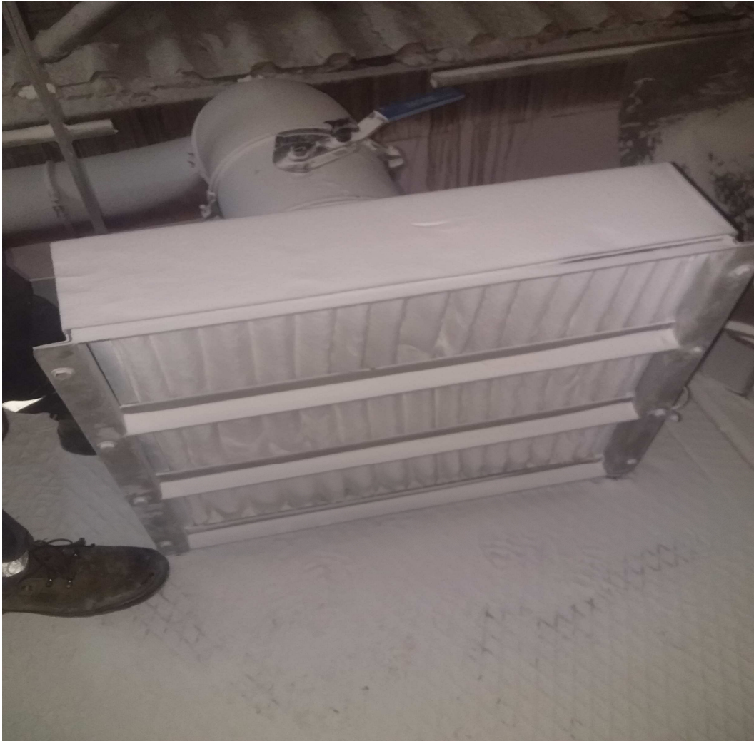
Figure.IV.27. Photographie du filtre à air.
