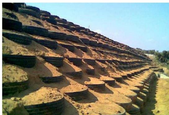
**Figure 1.9 :** Chantier expérimental de Pneusol à Bou-Smail en Algérie. (Trouzine, 2011)
