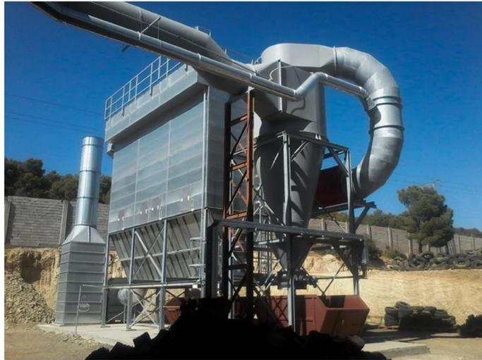
**Figure 2.51** : Photographie du filtre d'aspiration au sein de l'entreprise
