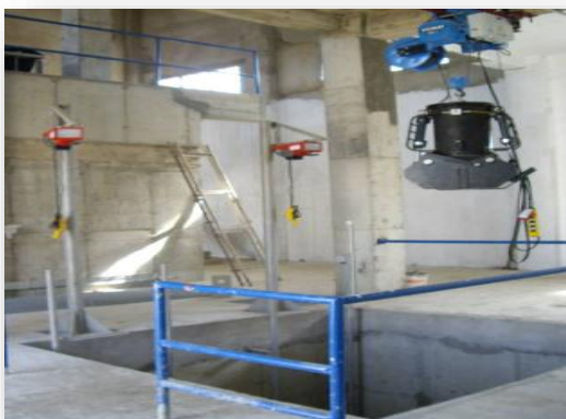
Figure I.3 : Le dégrilleur grossier.
