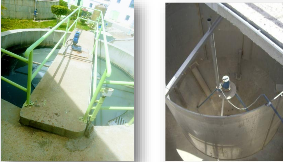
Figure I.5 : Le dessablage-déshuilage.
