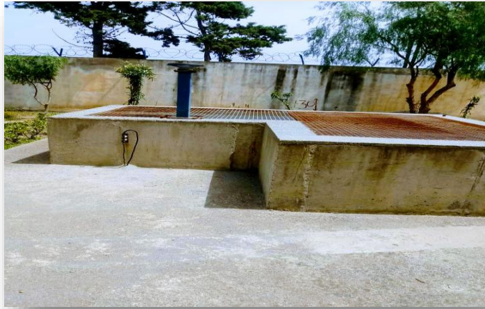
Figure I.2 : Arrivée des eaux usées dans la station.
