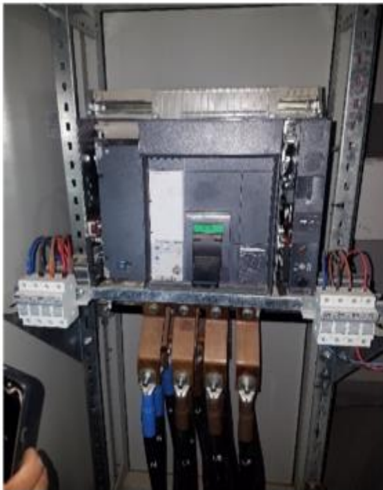
Figure II.5 : cellule protection générale (CLP) avec un disjoncteur magnétothermique
