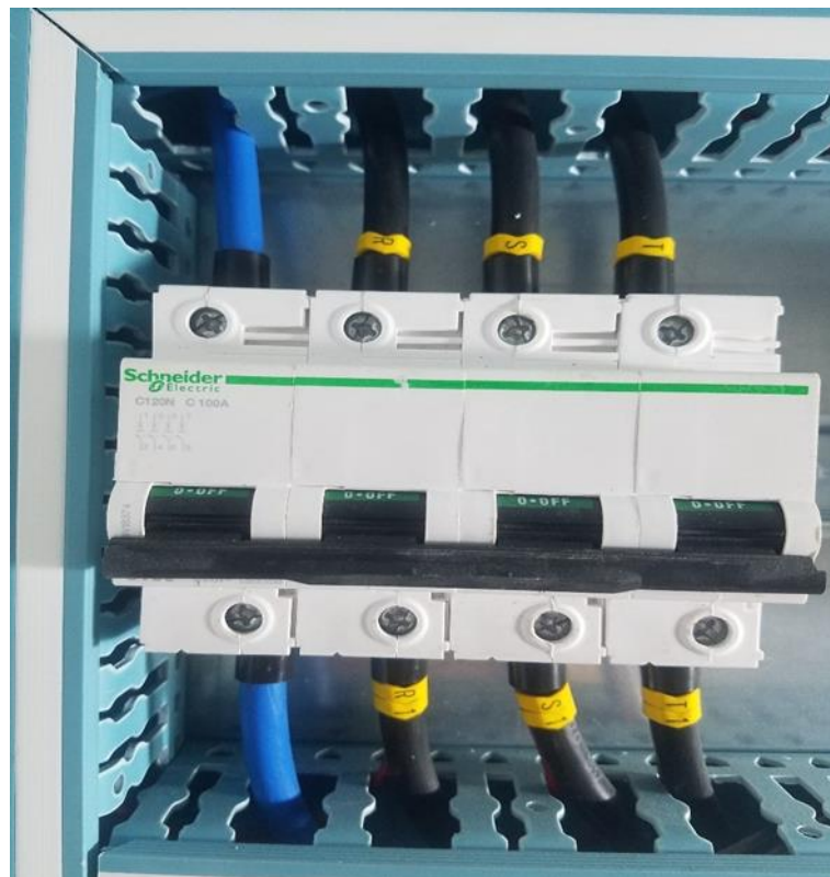
Figure II.34 : Disjoncteur d'alimentation C120N C 100A
