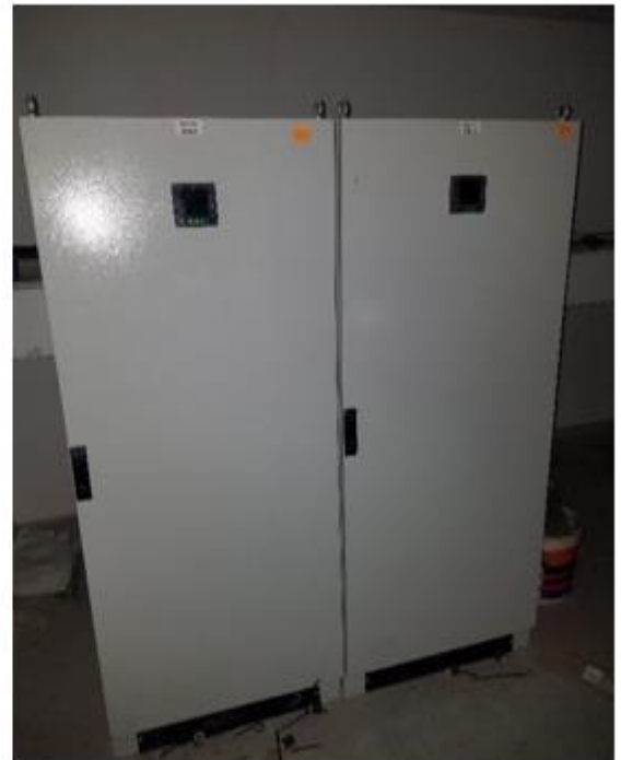
Figure II.5 : cellule protection générale (CLP) avec un disjoncteur magnétothermique
