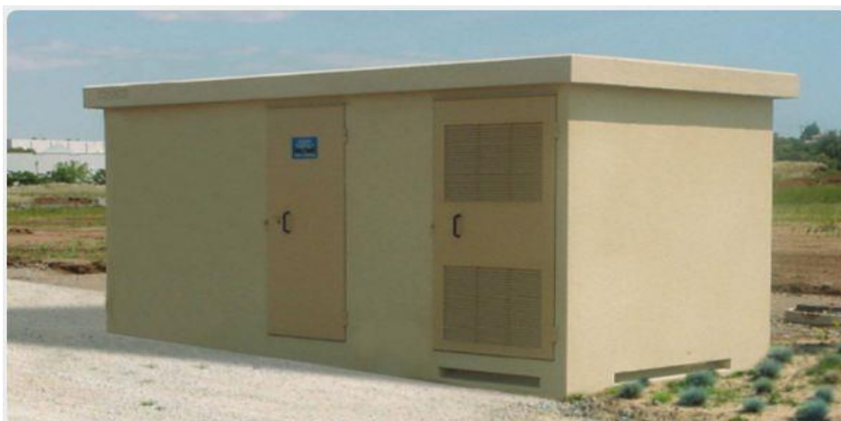
Figure 5 : poste préfabriqué MT/BT
