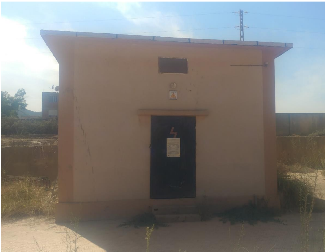
Figure 6 : Poste de distribution publique
