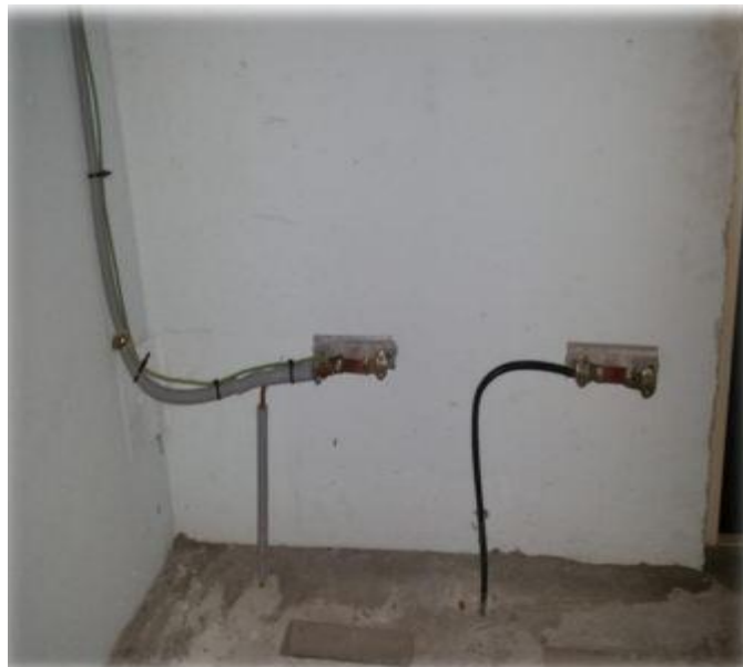
Figure 15 : Circuit de mise à la terre
