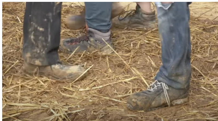
Figure 1. 3 : Foulage du mélange en piétinant [9]
