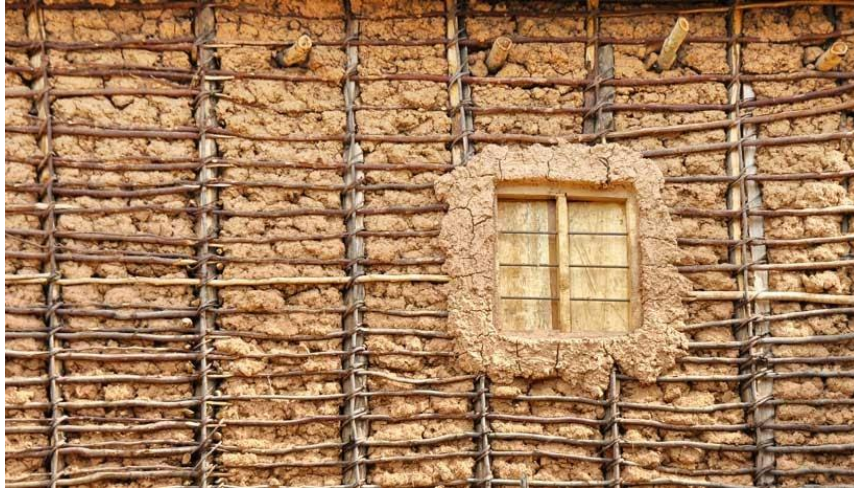
Figure 1. 4 : Remplissage des interstices d'une structure en bois[10]
