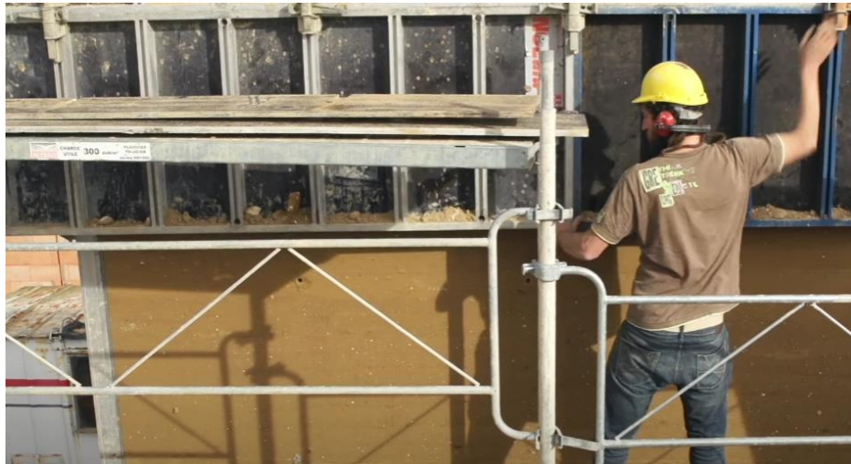
Figure 1. 2 : Décoffrage des murs en pisé [9]
