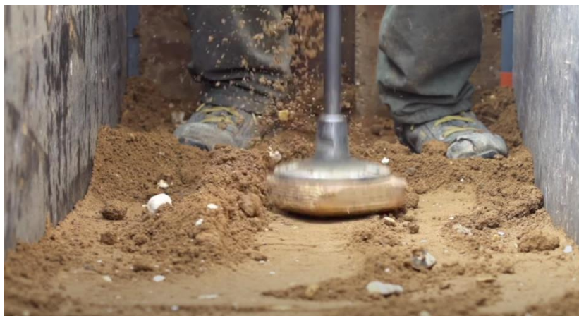
Figure 1.1 : Compactage des couches de terre crue à l'aide d'un pilon [9]
