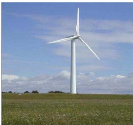
Eolienne à axe horizontal
