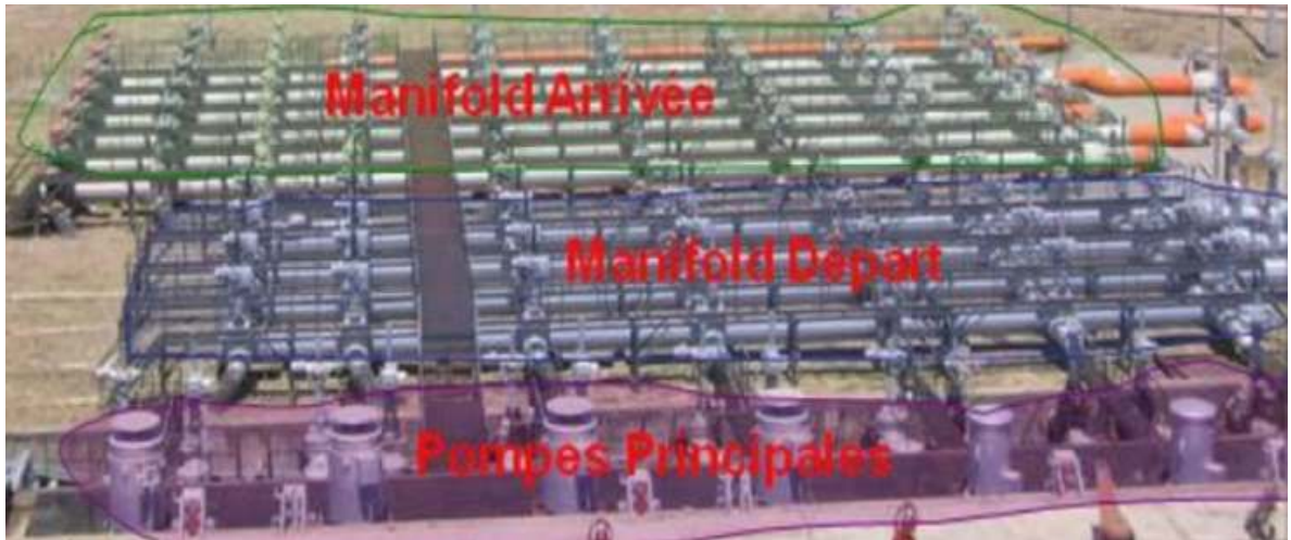
Figure I.3 : les manifolds départ et arrivée.
