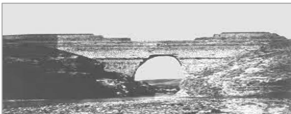
**Figure I. 11 :** Etat du barrage puentes (Espagne) après la rupture (Schuster ,1986)
