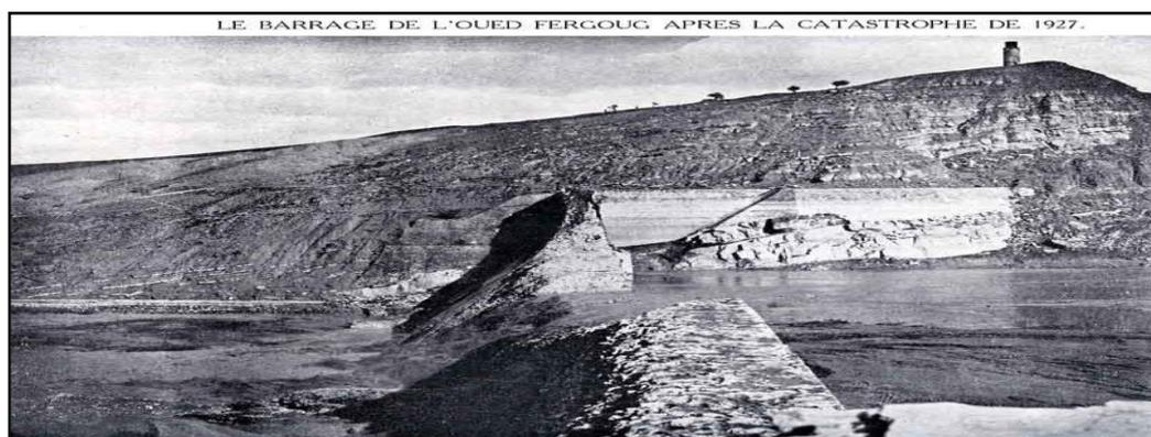
**Figure I. 15 :** *Vue du Barrage Fergoug après la rupture du 25 novembre 1927(Bruel ,1959)*
