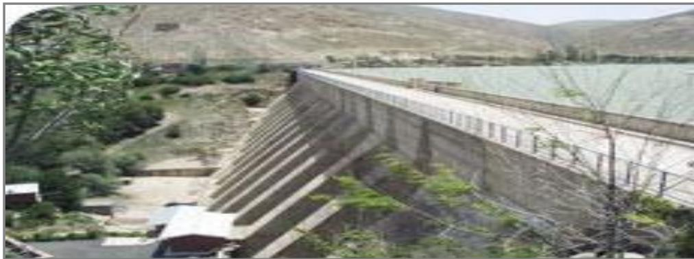
**Figure I. 5:** Barrage à contreforts d'Ekbatan (Iran) (Mihoubi, 2012)
