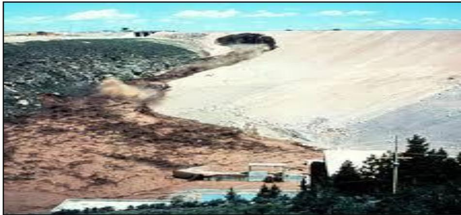
**Figure I. 14 :** *Le barrage Grand Teton (USA) après la rupture (Marche, 2004)*
