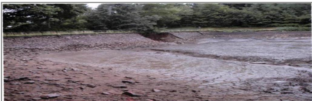
**Figure I. 9** : Rupture de barrage des Ouches par érosion interne (Chanson, 2006)
