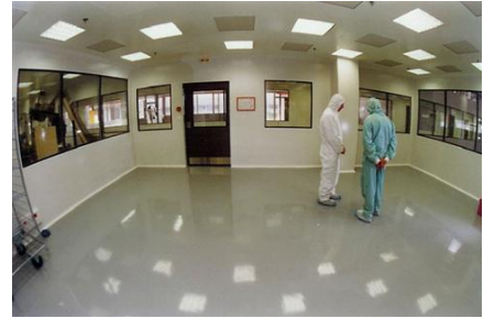
Figure 5-13 : Sol auto lissant source : idem
